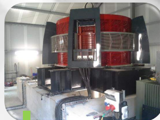
6 Phase de raccordement : mise en place et câblage de l'alternateur
