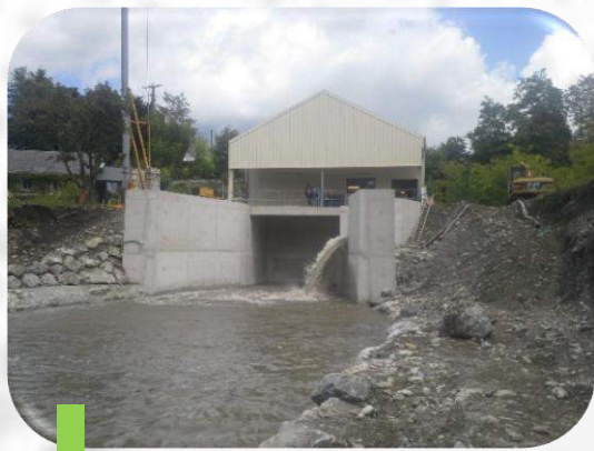
8 Phase finale : première mise en route de la centrale Hydro Les Vignes
