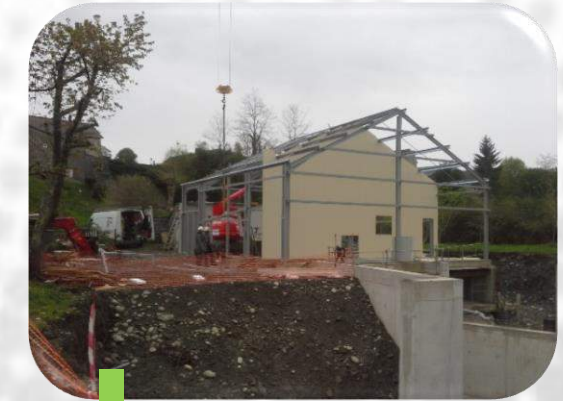
4 Phase construction : réalisation du bâtiment de la centrale
