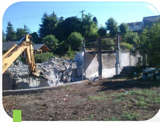
1 Phase de démolition : sciage de la centrale devant les anciennes vannes
