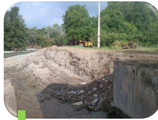
2 Phase Génie Civil : terrassement
