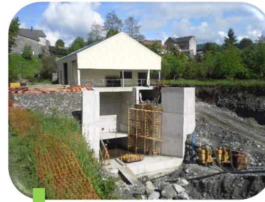
3 Phase Génie Civil : mise en place des voiles aval
