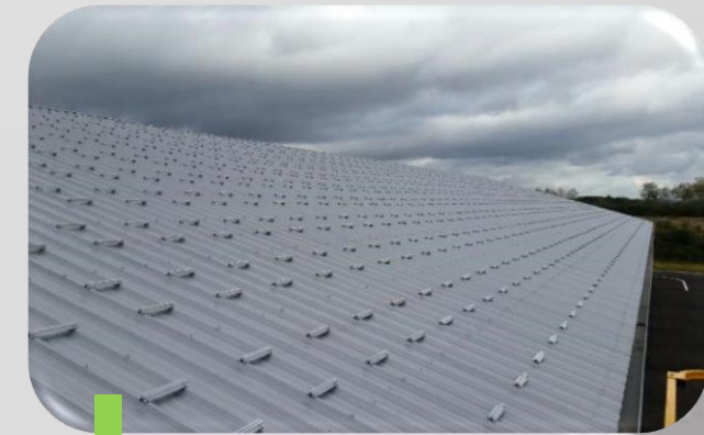
2 Système d'intégration : Pose des rails supportant les panneaux photovoltaïques
