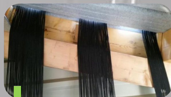
4 Câblage : Raccordement des chaînes de panneaux et des onduleurs fabriqués en Ardèche
