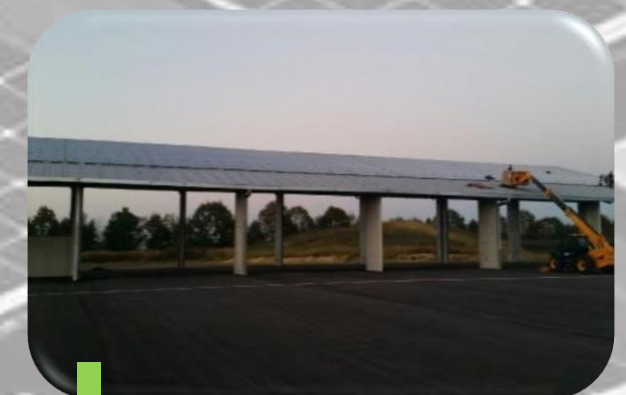
3 Panneaux photovoltaïques : Pose, fixation et câblage des modules photovoltaïques
