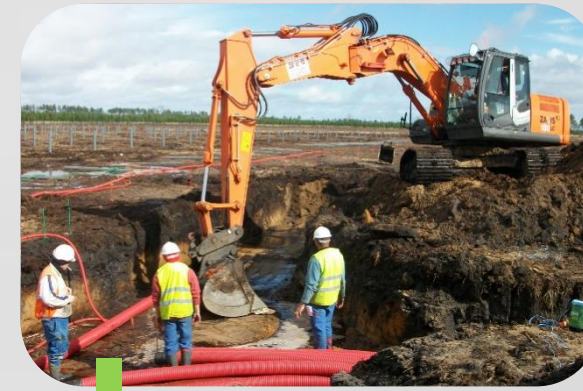
2 Préparation du terrain et passage des câbles
