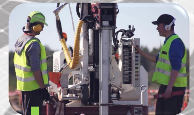
4 Battage des pieux
