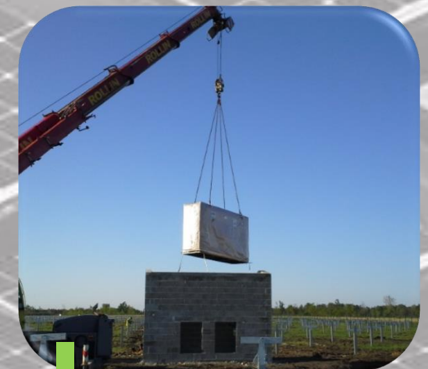
5 Installation des onduleurs
