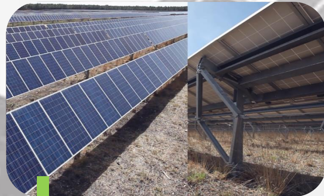
8 Mise en service du parc
