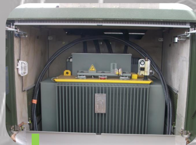
6 Installation des postes de transformation
