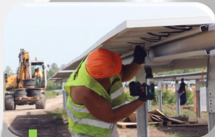
7 Mise en place des modules photovoltaïques
